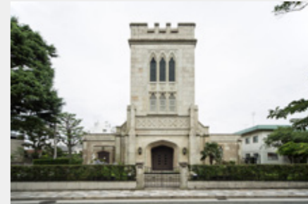
所在地：横浜市中区山手町235 建築年代：1931年 [平成2（1990）年3月] 設計：H・モーガン 施工：不詳
